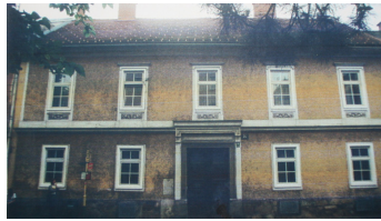
Abb. 7: Das Haus Merangasse 24 (vor der letzten Renovierung)
