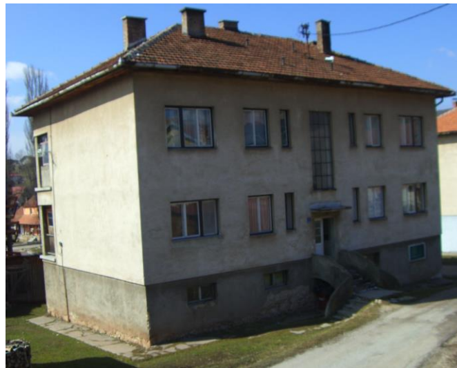
Kuća u Kalinoviku sa stanom Đorđa Tošovića (1. sprat, lijevo od ulaza), sada ulica Omladinska 5 (snimljeno 23. marta 2009)
